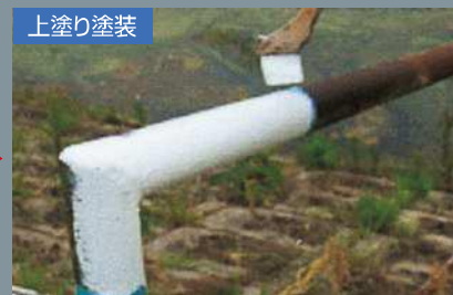
乾燥後、一般塗料で上塗り塗装。
