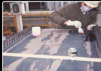
給炭機の石炭運送用ベルコンの補修
