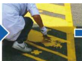
塗布面をゴムベラ等で均一にし、約1~2mm厚程度に塗り広げます。
