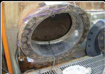
循環水管マンホールのゴムライニング補修
